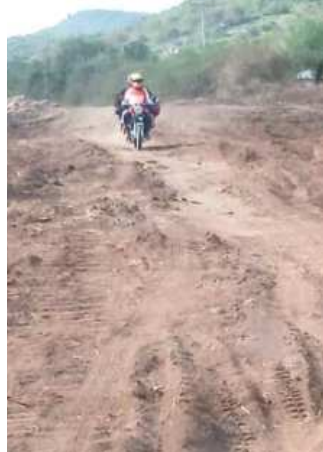
Straße soll bald fertig sein
